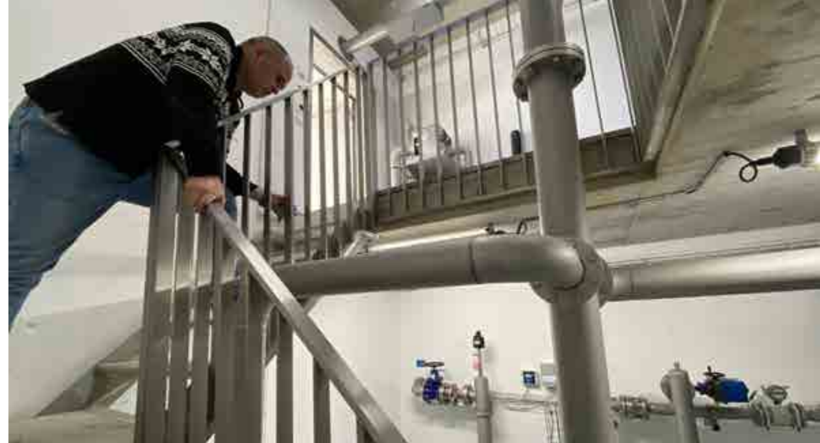
Christian Cornioley, conseiller communal, très satisfait d'un chantier conduit sans accident et conformément à la planification
