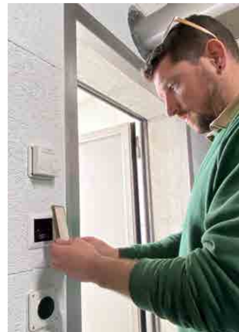
Romain Viquerat extrayant les données d'exploitation de l'ouvrage au moyen d'un lecteur à distance.
