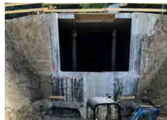
Vue de la remise en conformité de l'ouvrage, réalisée courant 2023.
